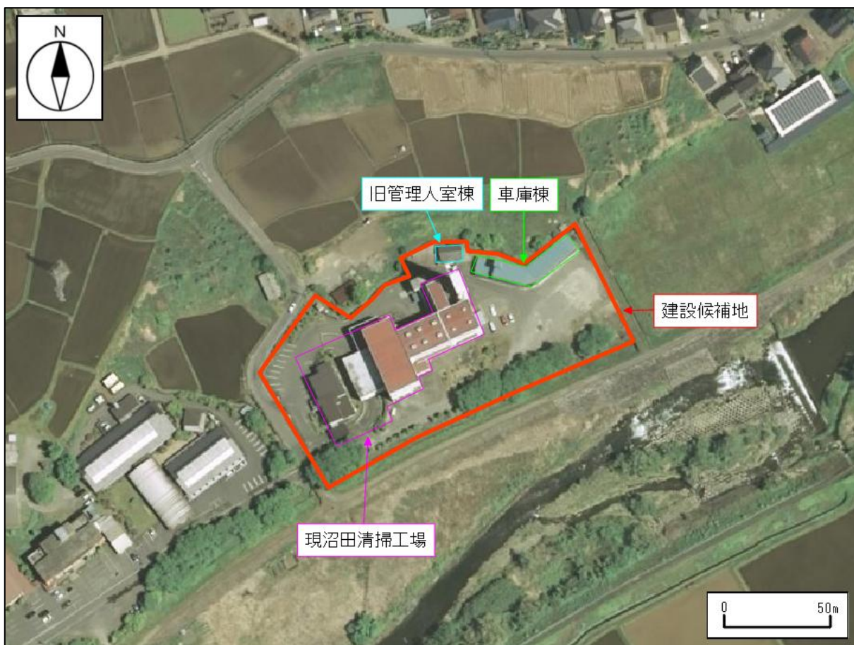
図 2.1 建設候補地の状況
